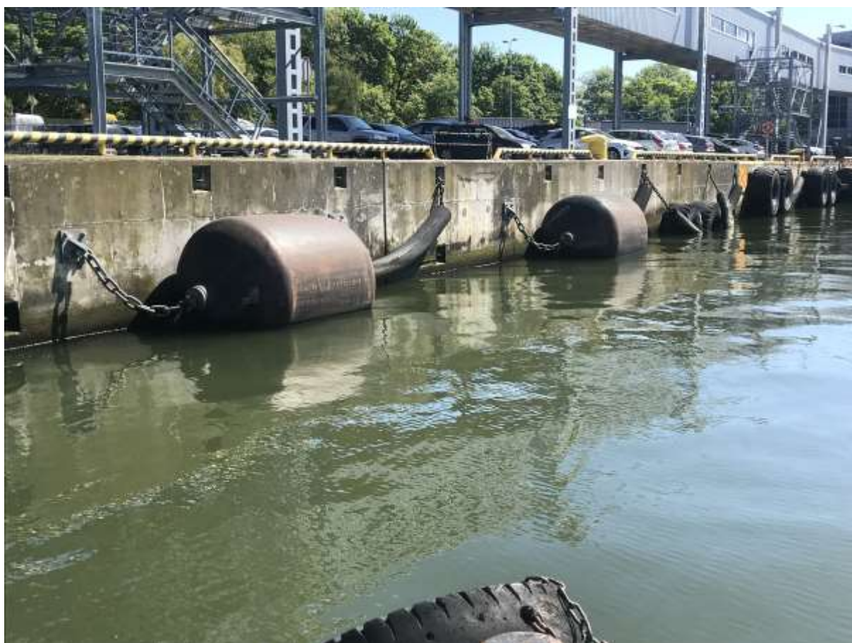
Fot. 4 – odbojnice typu Yokohama w rejonie terminala promowego
